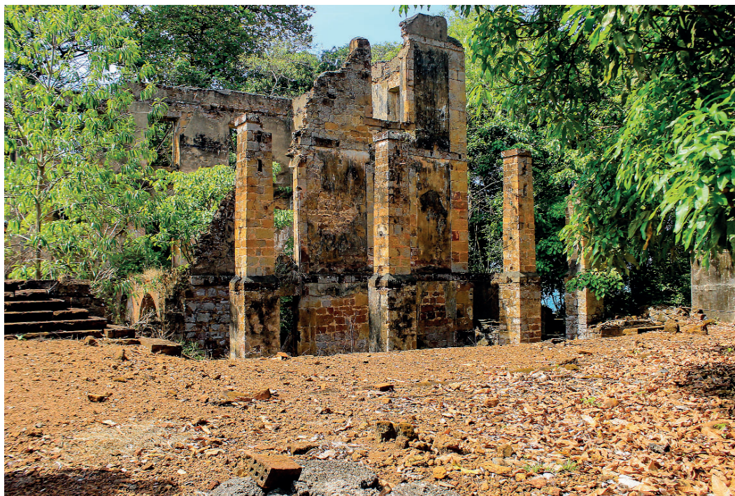
Les briques des îles du Salut sont les éléments les plus pillés du patrimoine guyanais. Quand elles ne servent pas de « déco », elles sont mises en vente sur les sites marchands comme Leboncoin / photo AG
